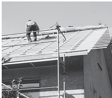
Zde bylo při zateplení střechy obnoveno veškeré latování.
