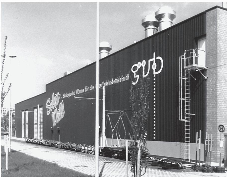
Obr. 21.1 Jižní strana haly lakovny je celoplošně pokryta kolektory Solarwall
