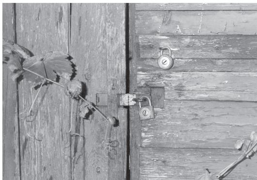
**Obr. 10.2** Nevhodné uzamčení kůlny visacími zámky s petlicí
